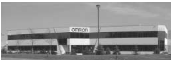
Usine Omron Dualtec à Oakville (Ontario).
